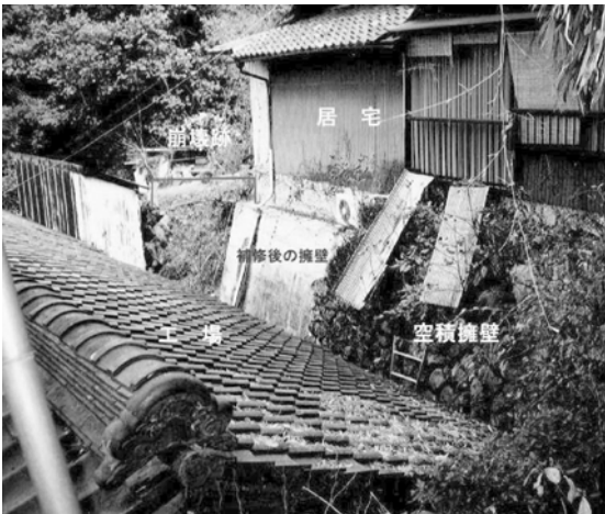
写真-1 鑑定対象の擁壁 (写真中央部の石積擁壁)
